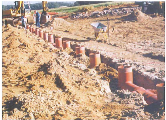
Studse på rør
